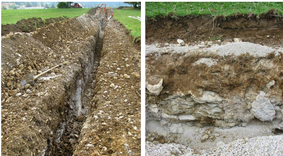
Fig. 11 > Chantier en zone de montagne du Jura – pose d'une ligne électrique souterraine appartenant à la BKW Berne SA
