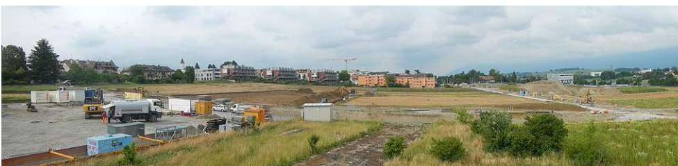
Fig. 47 > Vue panoramique du chantier «Les Vergers» à Meyrin (GE)
