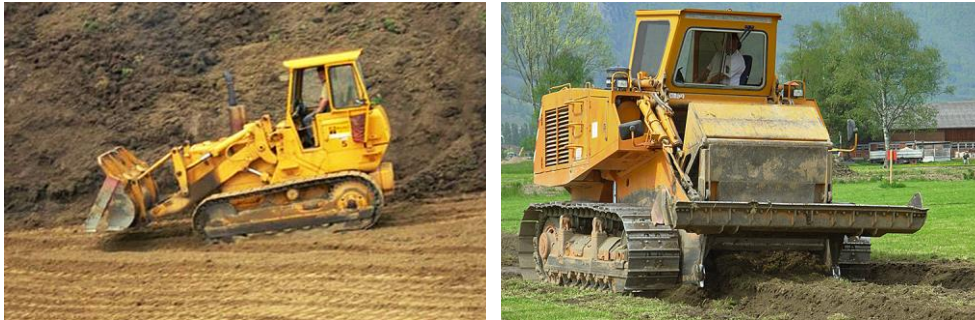
Fig. 29 > Trax et scrape dozer
