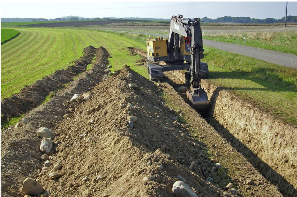
Fig. 28 > Fouille linéaire avec pelle hydraulique à chenilles sur sol en place enherbé
