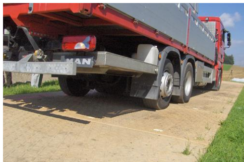
Fig. 33 > Plaques mobiles emboîtables
