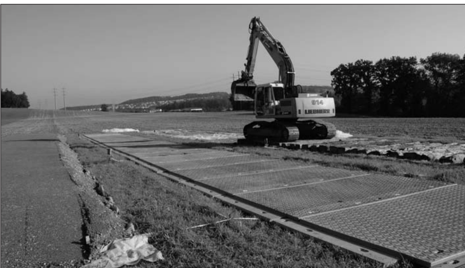
Pistes de protection des sols. De gauche à droite, la piste de grave, la piste Durabase® et la piste en rondins.
