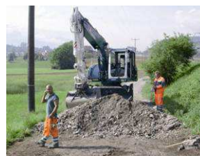
Déconstruction d'une piste, en reculant et en circulant sur la piste
